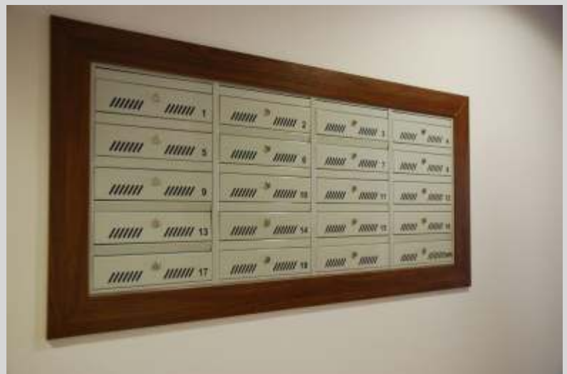
zestaw czterech skrzynek 5-skrzytkowych, wbudowany w rame drewniana
